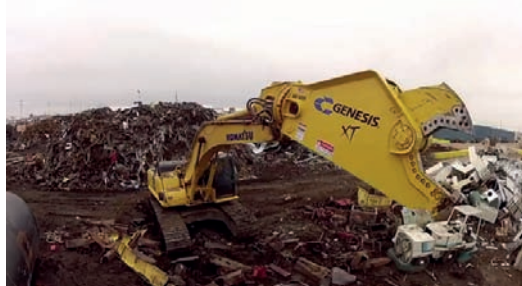
Rys. nr 4 i 5. Nożyce do cięcia złomu oraz prac wyburzeniowych firmy Kinshofer i Genesis (oprzyrządowanie doczepiane do dźwign
