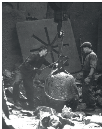
Rys. 20 i 21. Przedstawiają kafar i bijak (baba) do rozbijania złomu (druzgu) w dzielnicy Piekło Dąbrowy Górniczej Piekelski Zakład Przerobu Złomu / obecnie CUTIRON Shared Service (urządzenie kafarowe zdemontowano).
