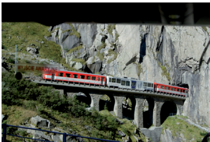
Fot. 4. Most kolejowy przez wąwóz powyżej mostów drogowych
