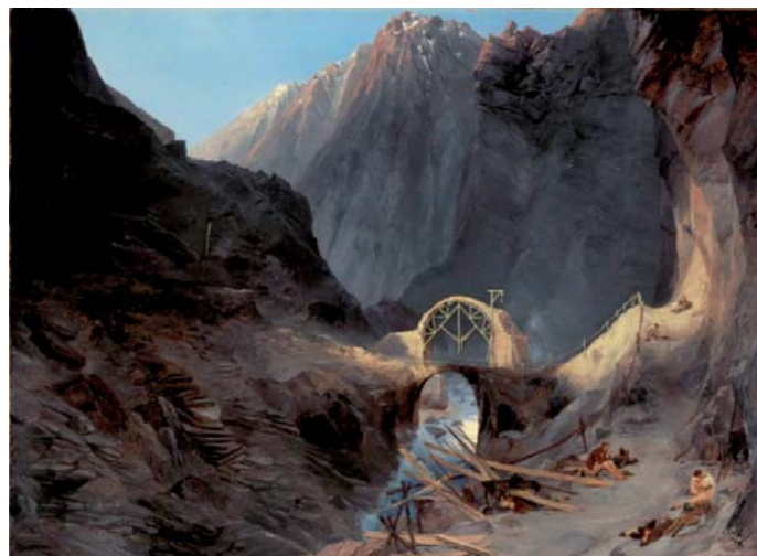
Fot. 5. Na pierwszym planie Pierwszy Most Diabła, w głębi Drugi Most Diabła w czasie budowy [1]
