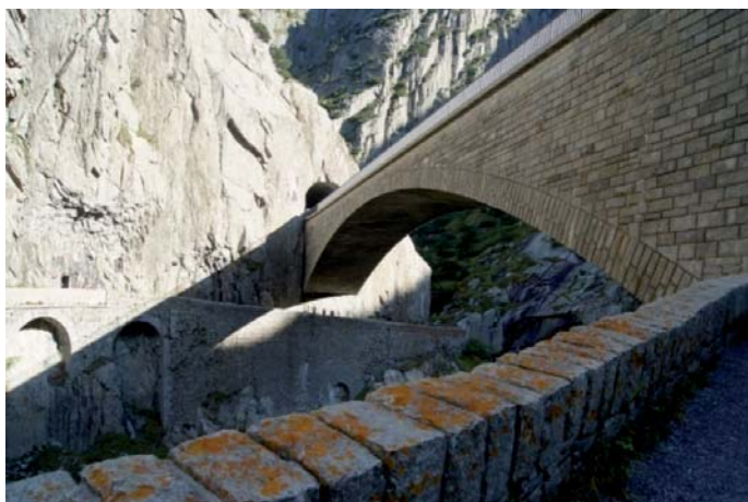
Fot. 3. Trzeci Most Diabła przechodzący w tunel
