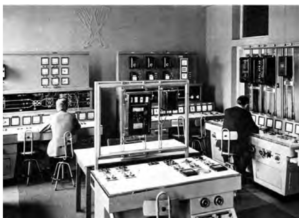
Rys.4. Laboratorium Katedry Sieci i Układów Elektroenergetycznych, lata 70.
