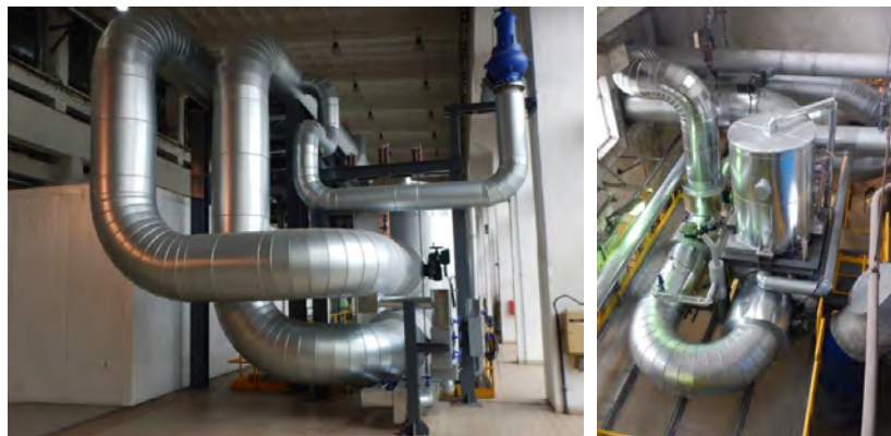
Zdj. 4, 5. Rurociągi pary do wymiennika podstawowego (lewy) i do wymiennika szczytowego (prawy)
