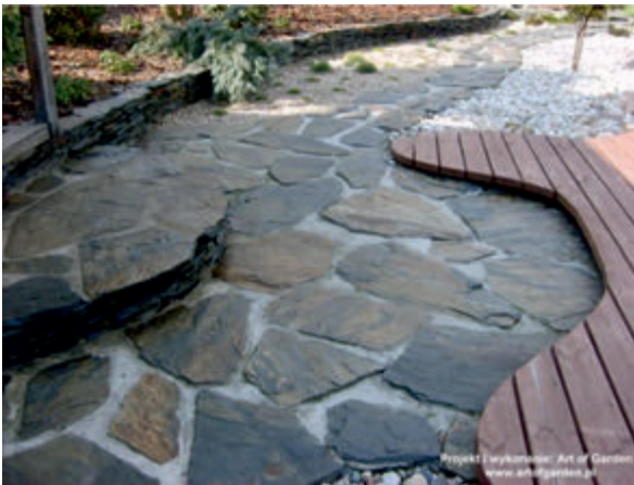
Rys. 3. Ścieżka ogrodowa, stopień i murek wykonane z łupka jenkowskiego ( www.lupek-jenkow.pl/kamien-sieczkowy-118.htm )
