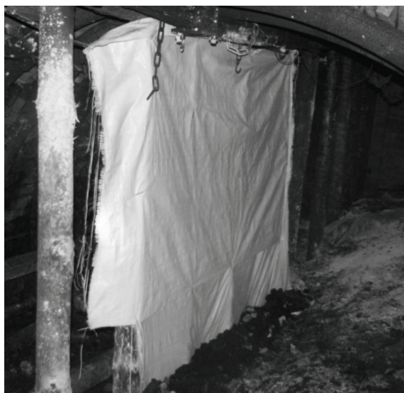
Rys.1. Widok tamy zamontowanej w kopalni węgla kamiennego [9]
