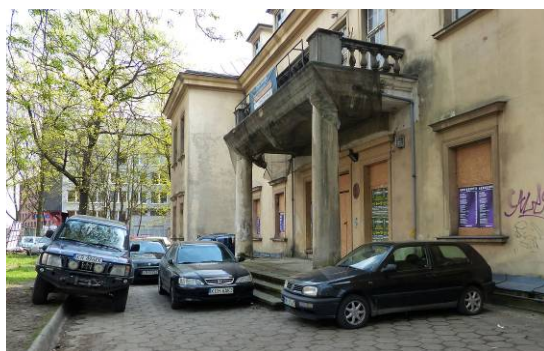
Ryc. 11. Kraków, podjazd budynku przy ul. Szlak. Nieuregulowana struktura własności sprzyja tu zawłaszczaniu zaniedbanych stref w centrum miejskim. /fot. J. Kurek/
