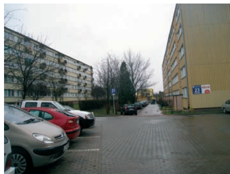
Fot. 4. Wprowadzenie miejsc postojowych wzdłuż alejki osiedlowej jako element kolizyjny z układem urbanistycznym
