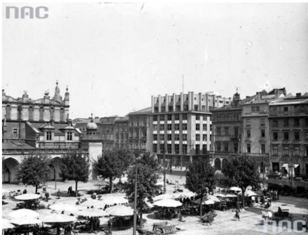
Il. 4. Budynek Wiedeńskiego Towarzystwa Ubezpieczeniowego „Feniks”, Rynek Główny w Krakowie, Polska, autor: Adolf Szyszko-Bohusz, widok po wybudowaniu w 1932 roku.
