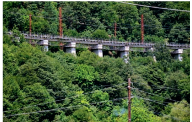
Ryc. 21. Betonowy most kolejowy w dolinie rzeki Debed
