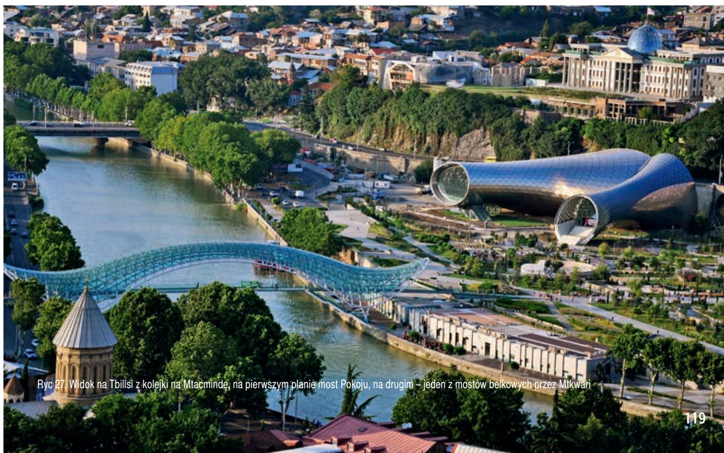
Ryc. 26. Jeden z żelbetowych mostów łukowych przez rzekę Mtkwari w Tbilisi
