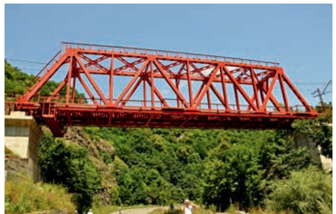
Ryc. 22. Nowoczesny stalowy most kolejowy w dolinie rzeki Debed
