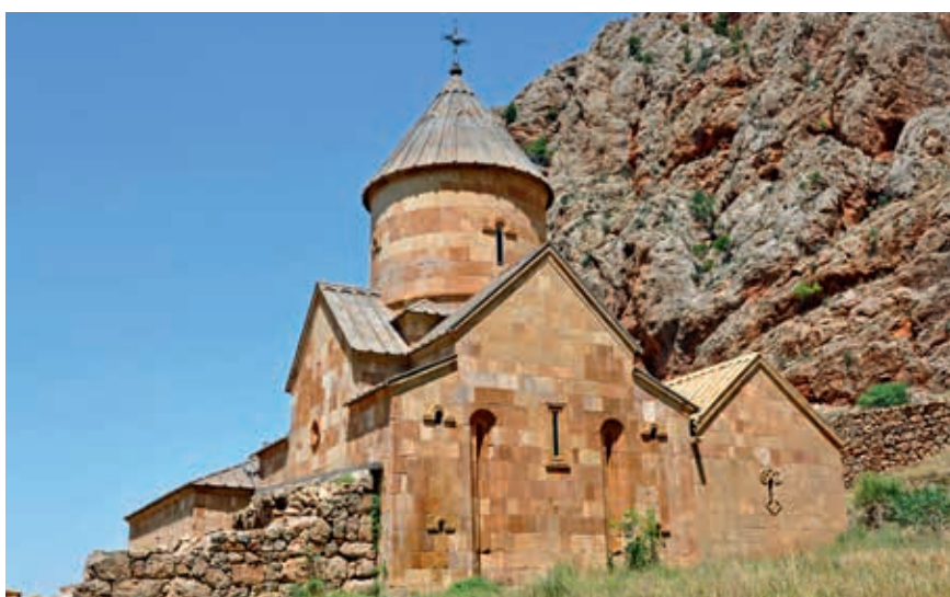
Ryc. 4. Kościół św. Jana Chrzciciela (Surp Karapet) w Norawank
