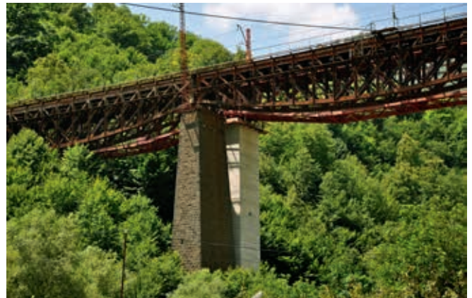
Ryc. 20. Stalowy most kolejowy w dolinie rzeki Debed
