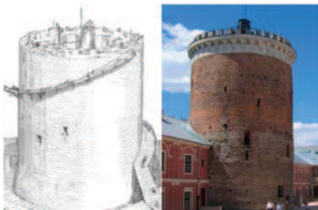
Rys. 11. „Bliźniacze” wieże we Francji i Polsce a) wieża w czasie budowy z rusztowaniami, Coucy [54]. b) istniejąca wieża z widocznymi otworami maculcowymi w Lublinie, fot. Małgorzata Nossowska
