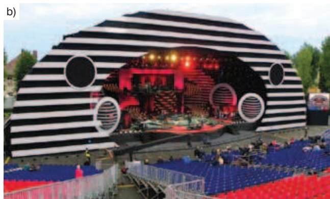
Rys. 19. Obiekty wykonane z elementów rusztowań, a) Łódź, fot. z archiwum firmy Altrad-Mostostal, b) tymczasowy amfiteatr i trybuna w czasie 47 KFPP w Opolu
