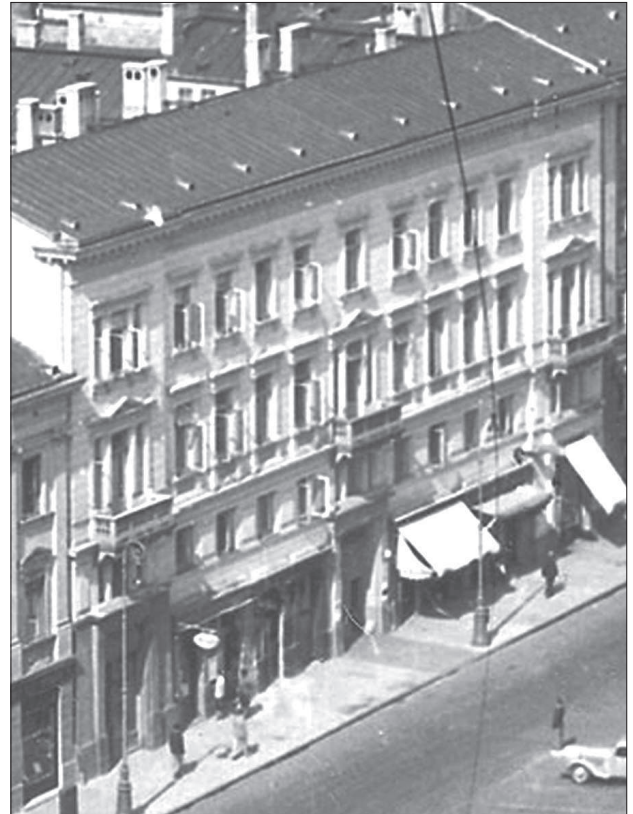
3. Kamienica przy ul. Erywańskiej 1066 Ł/16 (ob. ul. Kredytowa) w Warszawie wzniesiona na zlecenie Aleksandra Kruzeego przez Juliana Ankiewicza w latach 1859-1860 r., fot. przed 1939. Źródło: www.warszawa1939.pl (dostęp 14.10.2012) 3. Tenement house in Erywańska street 1066 Ł/16 (presently Kredytowa) in Warsaw, erected by order of Aleksander Kruze to the design of Julian Ankiewicz in the years 1859-1860, photo taken before 1939. Source: www.warszawa1939.pl (accessed 14.10.2012)
