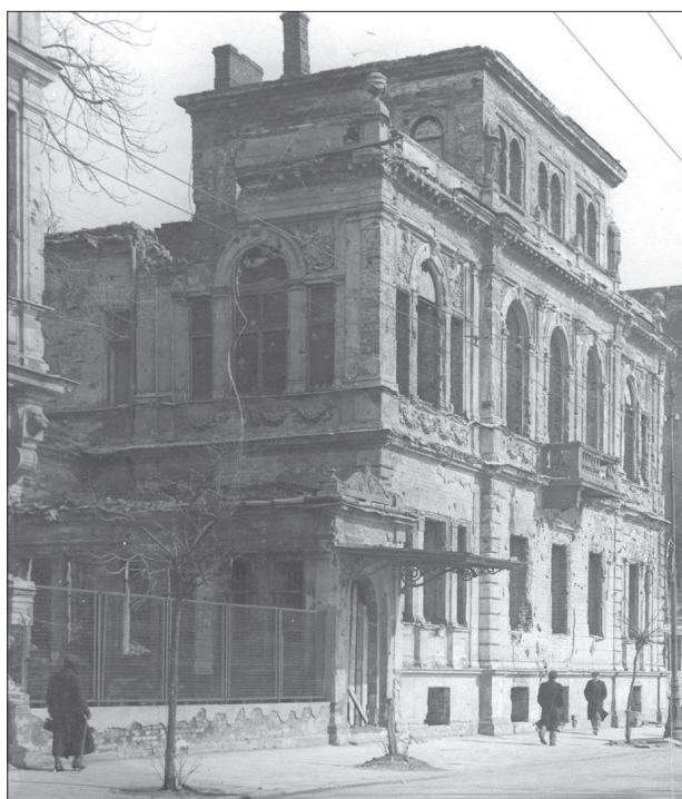
20. Willa przy ul. Pięknej nr hip. 1727H/6 w Warszawie, wzniesiona na zlecenie Aleksandra Kruzego przez Juliana Ankiewicza w latach 1866-1868, fot. 1946. Archiwum Urzędu Wojewódzkiego Konserwatora Zabytków, sygn. AZ BOS 998 20. Villa in Piękna street, land reg. no. 1727H/6 in Warsaw, erected by order of Aleksander Kruze to the design of Julian Ankiewicz in the years 1866-1868 photo taken 1946. Archives of the Voivodship Conservation Officer, file no. AZ BOS 998
