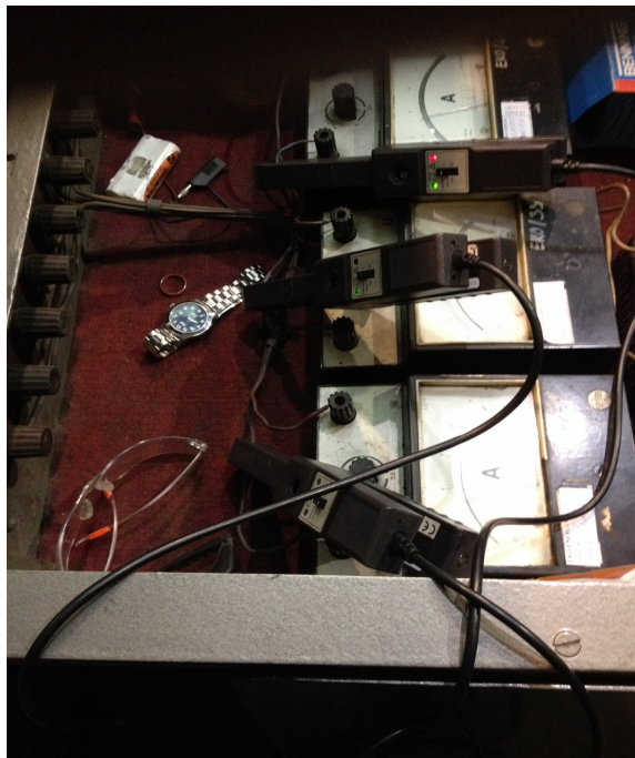
Rys. 3. Pomiar prądu w obwodach wtórnych przekładników prądowych przy pomocy hallotronowych sond pomiarowych
