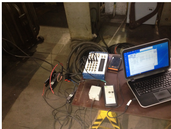
Rys. 11. Zestawiony układ pomiarowy do badania przekładnika na stacji prób
