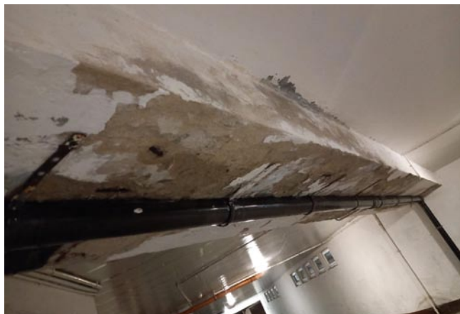
Rys. 7. Tymczasowe odwodnienie z rynien i rur spustowych zamocowanych osiowo do dylatacji pomiędzy dwoma podciągami
