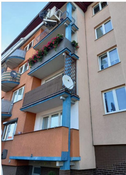
Rys. 10. Zabezpieczone antykorozyjnie i zagruntowane belki stalowe
