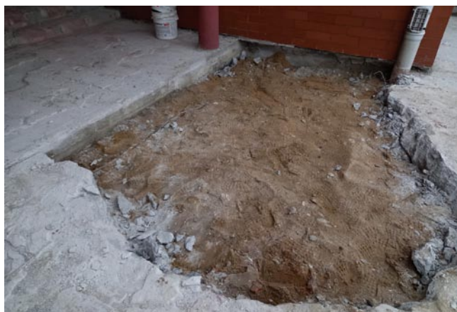
Rys. 2. Odkrywka spocznika, styk warstwy konstrukcyjnej spocznika ze stropem garażu podziemnego
