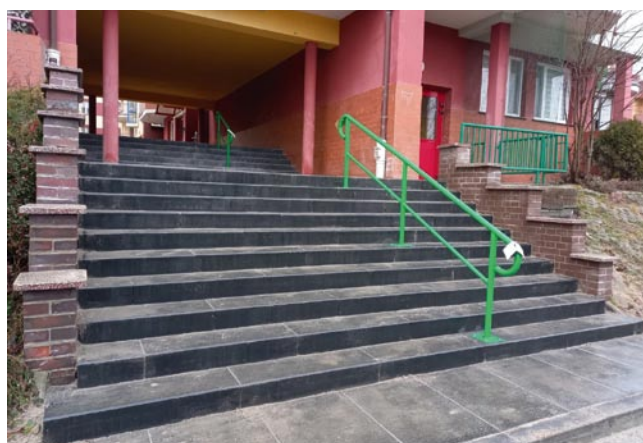
Rys. 5. Dolny bieg schodowy z zamocowanymi barierkami pośrednimi
