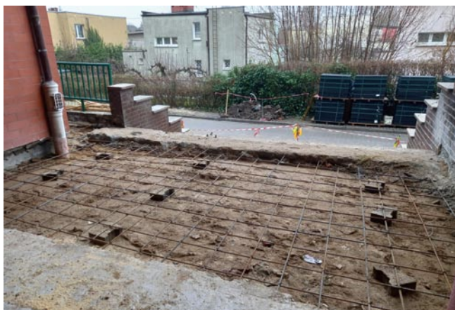
Rys. 3. Zbrojenie spocznika
