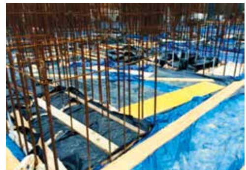
Rys.10. Pielęgnacja termiczna betonu masywnego
