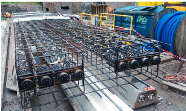
Ryc. 7. Zakotwienie bierne oraz przebieg prac sprężających – widok od spodu kosza zbrojeniowego
