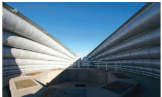
Rys. 14. Przekrycie z komorami nośnymi tworzącymi formę powierzchniową. Obserwatorium astronomiczne, średnica 15 m, Teneryfa, Hiszpania (2008) (rys. www.archiexpo.com)
