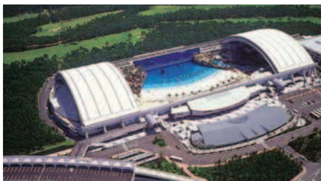
Rys. 1. System z równoległym przesuwem sztywnych paneli pokrytych membraną, Seagaia Ocean Dome, Japonia (1993), wymiary 100×300 m (rys. www.amusing-planet.com )
