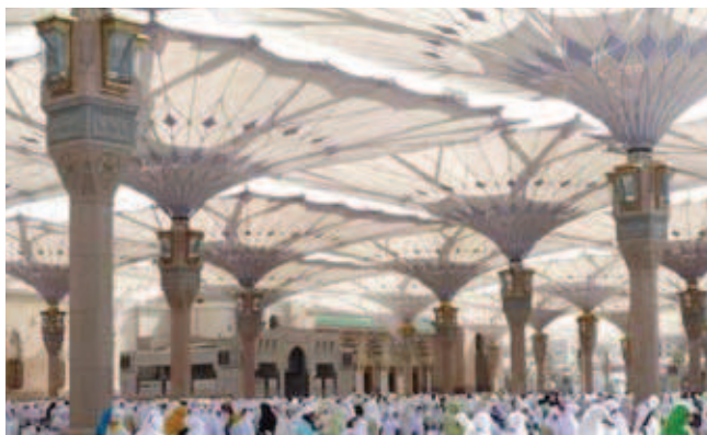
Rys. 9. Składane osłony przeciwsłoneczne w formie parasoli, meczet w Medynie (2011), proj. Bodo Rasch (źródło: jo.arabiaweather.com)
