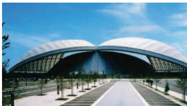
Rys. 2. System z obrotowym przesuwem sztywnych paneli pokrytych membraną, Tsugaru Dome (2002), połowy czasu rozchylają się na boki, rozpiętość 112 m (rys. tsugaru-kokusetsu.blogspot.com )
