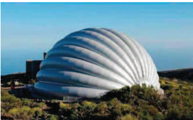
Rys. 14. Przekrycie z komorami nośnymi tworzącymi formę powierzchniową. Obserwatorium astronomiczne, średnica 15 m, Teneryfa, Hiszpania (2008) (rys. www.archiexpo.com)
