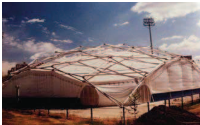
Rys. 10. Dach basenu w Sewilli, system nożycowo składanej siatki prętów, proj. F. Escrig, J. Sanchez (źródło: www.tensinet.com)
