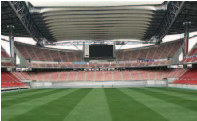
Rys. 13. Akordeonowy system składania dachu z poduszkami napelnianymi powietrzem, Toyota Stadium, Aichi, Japonia (2001), arch. Kisho Kurokawa (rys. skyscrapercity.com, schemat [3])
