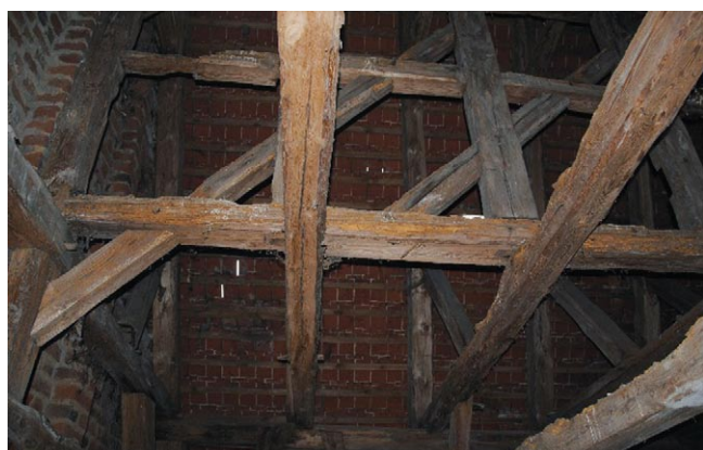
Rys. 7. Ugięte jętki i rygle
