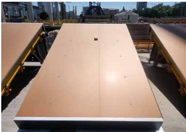
Fot. 2. Deskowanie z powłoką plastikową przygotowane do montażu
