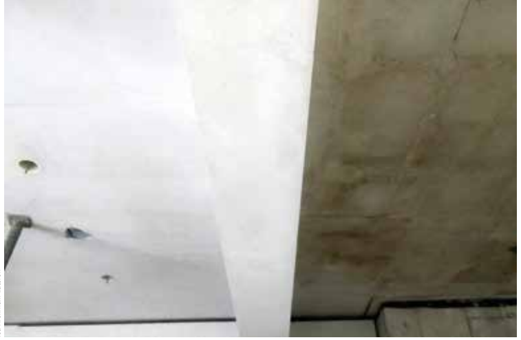
Fot. 12. Strop i belka wykonane z użyciem maty (z lewej) oraz strop bez zabezpieczenia (z prawej)
