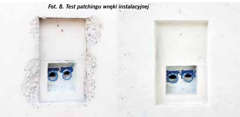
Fot. 8. Test patchingu wnęki instalacyjnej
