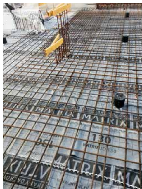
Fot. 11. Deskowanie stropu zabezpieczone matami
