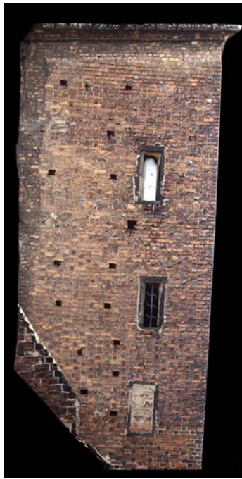
Ryc. 2. Dom Kapituły Katedralnej, wieżowy aneks południowy: A – stan sprzed konserwacji, fot. M. Chorowska, B – elewacja zach. aneksu wykonana metodą ortofoto, oprac. Laboratorium Skanowania i Modelowania 3D Politechniki Wrocławskiej, C – stan po konserwacji, fot. M. Chorowska. Za hipotezą mówiącą o równoczesnej budowie wieży pld. z domem głównym przemawia zastosowanie w licu aneksu wieżowego zendrówek w regularnym wątku kowadełkowym, identycznym, jak na pozostałych elewacjach domu. Obraz C pokazuje odchylenie aneksu od pionu
