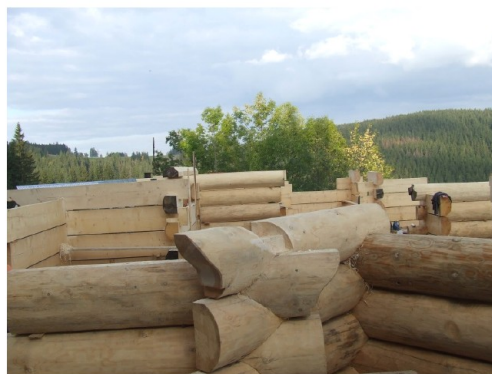
Ryc. 7. Konstrukcja zrębowa z całym zestawem różnych typów węglów (fot. J. Łaś)
