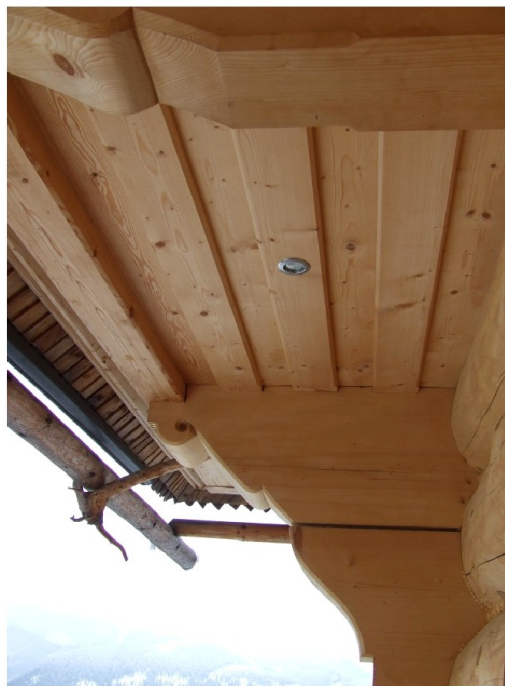
Ryc. 9. Zwieńczenie budowy zrębu rysiami i wspartą na nich ozdobiennie szalowaną futrzną, z czoła zamkniętą obzajtem (fot. J. Łaś)
