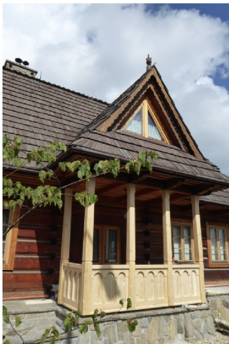
Ryc. 8. Słupowa konstrukcja ganku drewnianego domu (fot. J. Łaś)
