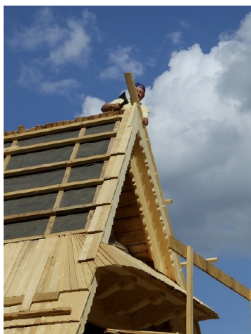
Ryc. 12. Krycie gontem i ozdobne wykańczenie szczytu (fot. J. Łaś)
