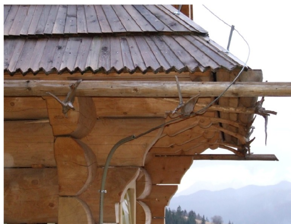
Ryc. 11. Okap gontowego dachu z systemem drewnianych rynien (fot. J. Łaś)
