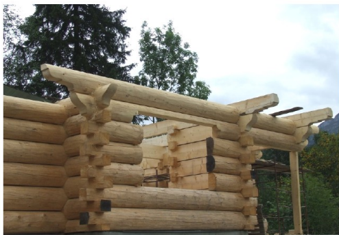
Ryc. 4. Zrąb drewnianego domu z widocznymi węglami narożnymi: zewnętrznymi i wewnętrznymi, gładkimi i z obłapem (fot. J. Łaś)
