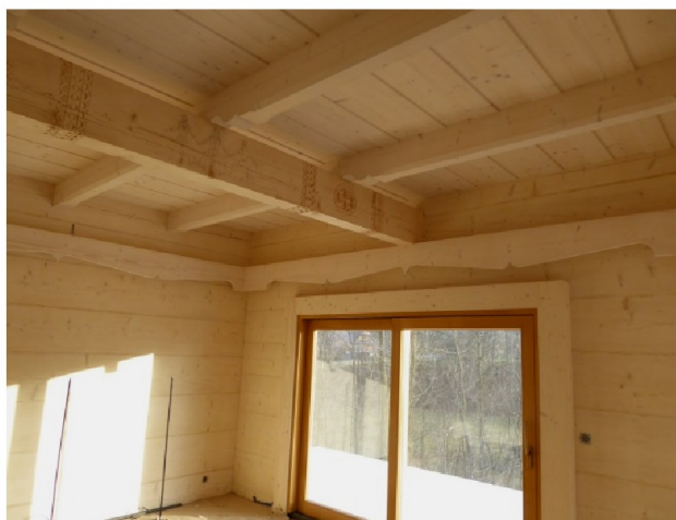
Ryc. 15. Rozsuwane drzwi balkonowe osadzone w zrębie drewnianego domu (fot. J. Łaś)
