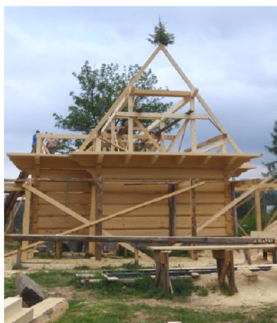
Ryc. 10. Montaż więźby dachowej drewnianego domu (fot. J. Łaś)
