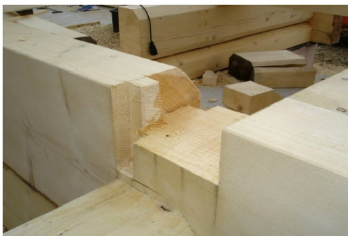
Ryc. 5. Wewnętrzna konstrukcja węgła półkrzyżowego z obłapem (fot. J. Łaś)
