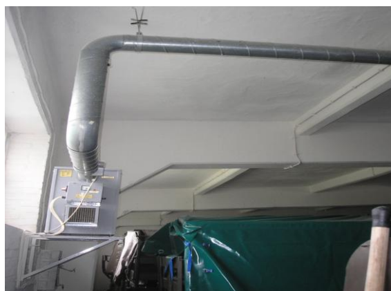
Rys. 8. Układ dystrybucji powietrza w garażu
