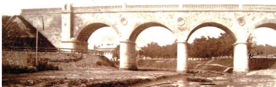
Rys. 5. Widok historyczny mostu nad Starą Wisłą przed jej zasypaniem w 1880 r. (Archiwum Narodowe w Krakowie / Gazeta Wyborcza)
