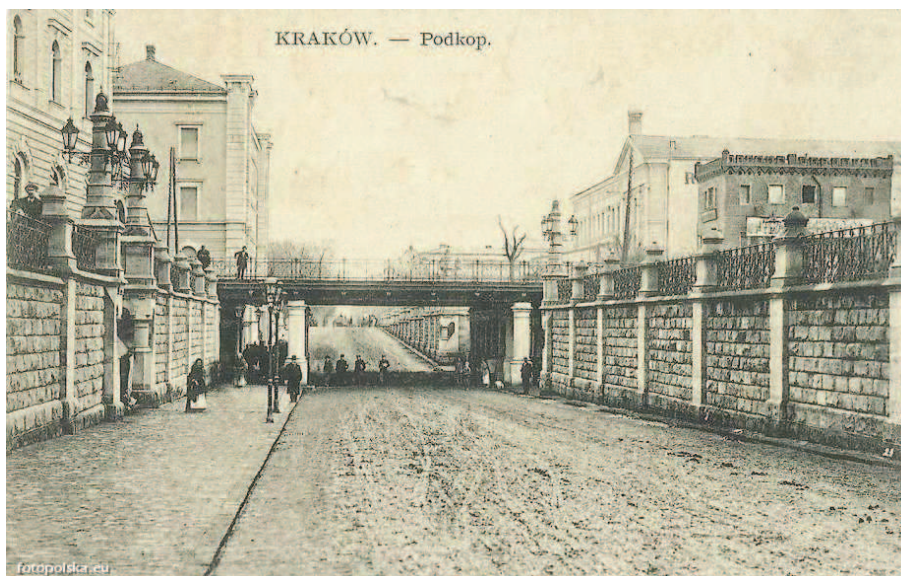
Rys. 3. Widok historyczny wiaduktu nad ul. Lubicz
