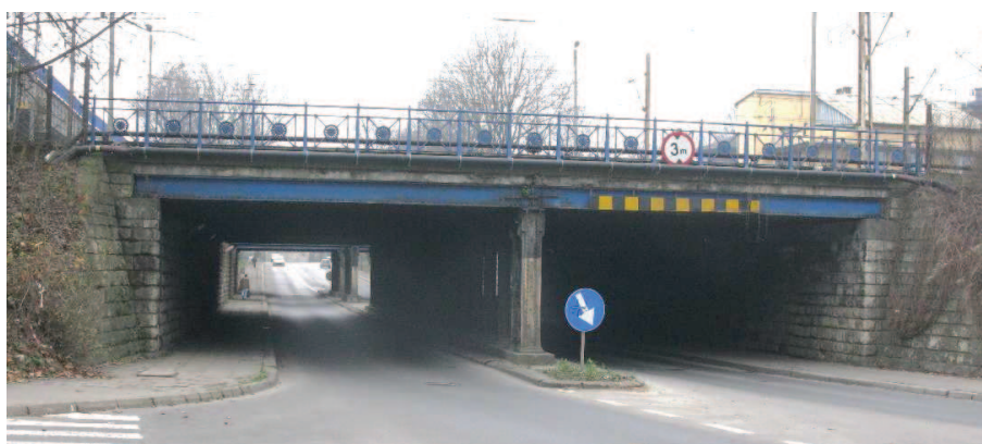
Rys. 2. Ogólny widok wiaduktu nad ul. Prądnicką od strony północnej
