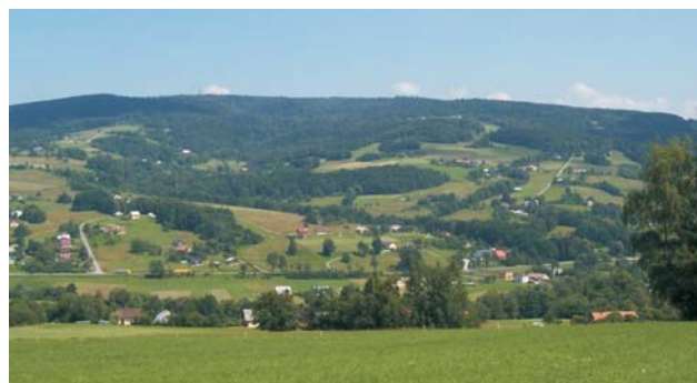
Ryc. 3. Dolina Szklarki obecnie, południowe stoki Maślanej Góry, w której w 1913 r. powstało katastrofalne osuwisko. Fot. E. Gil
