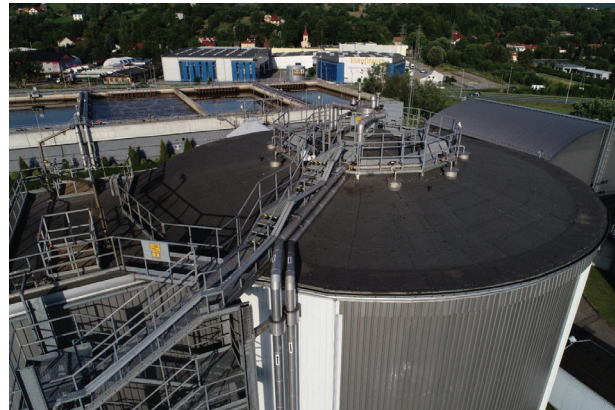
Fot. 3. Widok na dach obiektu WKF na terenie oczyszczalni ścieków
