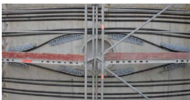
Rys. 10. Układ stalowych dewiatorów przy otworze technologicznym
