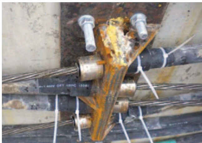
Rys. 11. Zabezpieczenie antykorozyjne przestrzeni między blachami oporowymi
