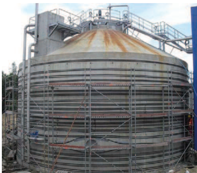
Rys. 9. Rozmieszczenie ciężni sprężających na wysokości ściany zbiornika
