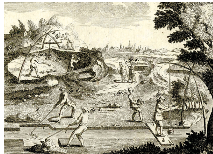
Ryc. 1. Wydobywanie rudy żelaza w płytkich powierzchniowych wyrobiskach oraz jej wstępne płukanie (Osiński, 1782a, Pl. III)
