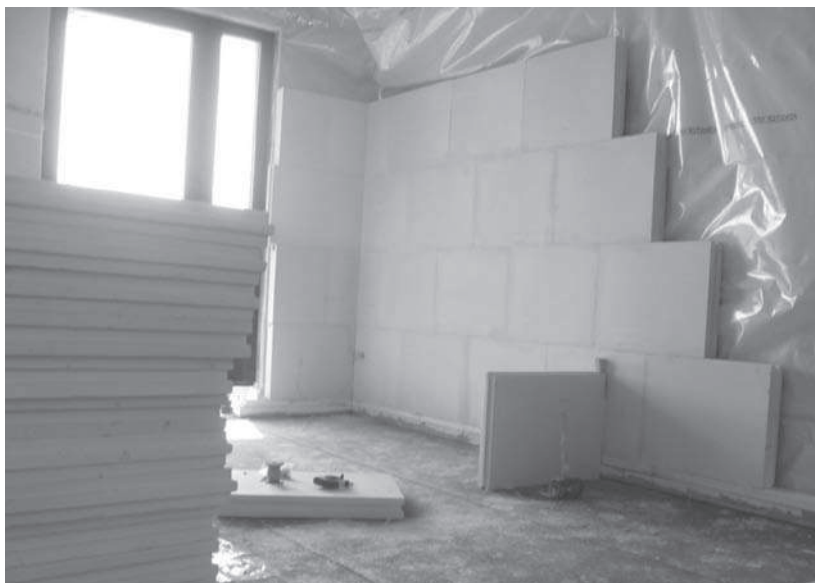
Rys. 2. Montaż ścian gipsowych na cokółach z polistyrenu ekstrudowanego
