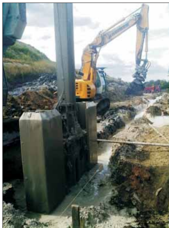
Fig. 4. Głębenie przesłony filtracyjnej
