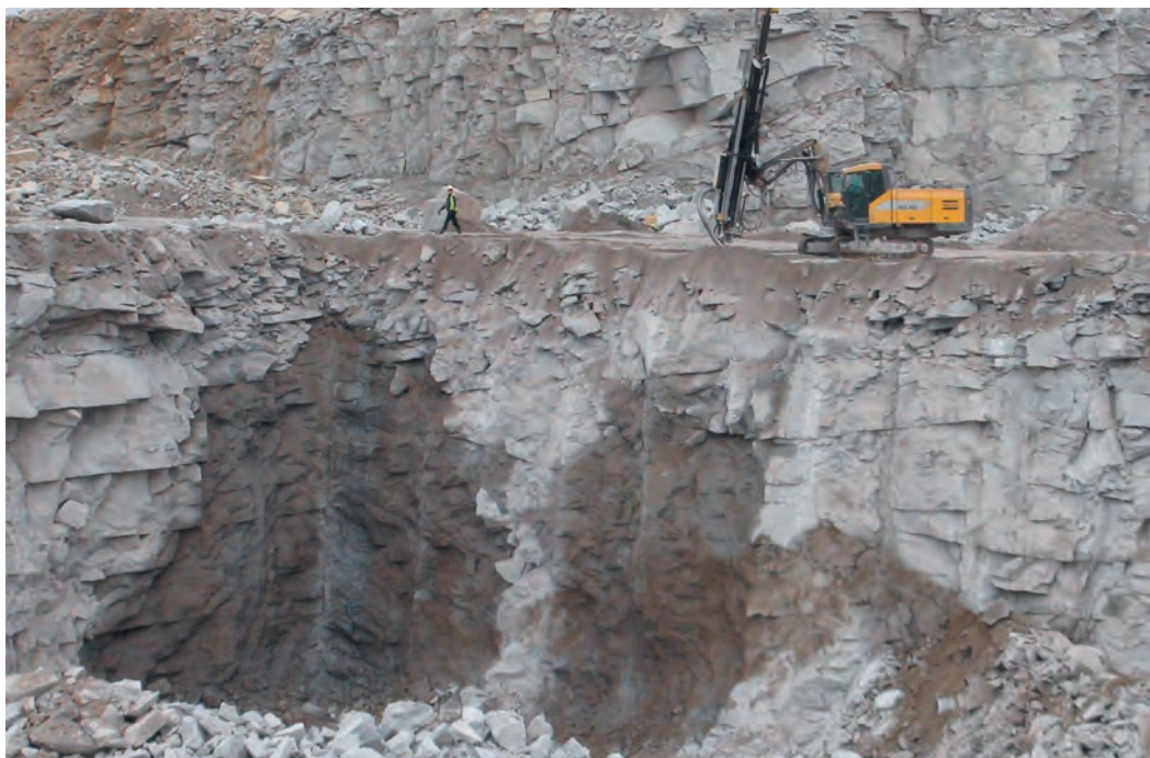
Fot. 1. Widok ociosu z wyciekami wody ze szczelin skalnych (źródło: materiały własne) Fot. 1. View of the highwall with water leaks from rock fractures (source: own material)
