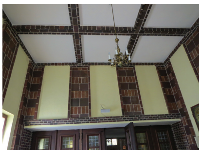
Fot. 12. Ostonięty strop Kleina i stalowe nadproże w kruchcie (fot. aut.)
