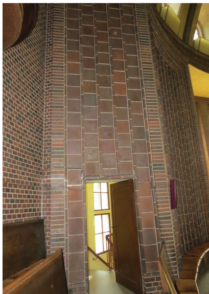
Fot. 10. Jeden z czterech masywnych aneksów stanowiących podstawę konstrukcji rotundy oraz empory (fot. aut.)
