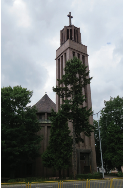
Fot. 3. Widok kościoła od strony wschodniej (fot. aut.)
