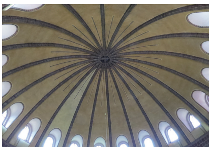
Fot. 7. Kopuła z widocznymi gurtami maskującymi dźwigary stalowe (fot. aut.)
