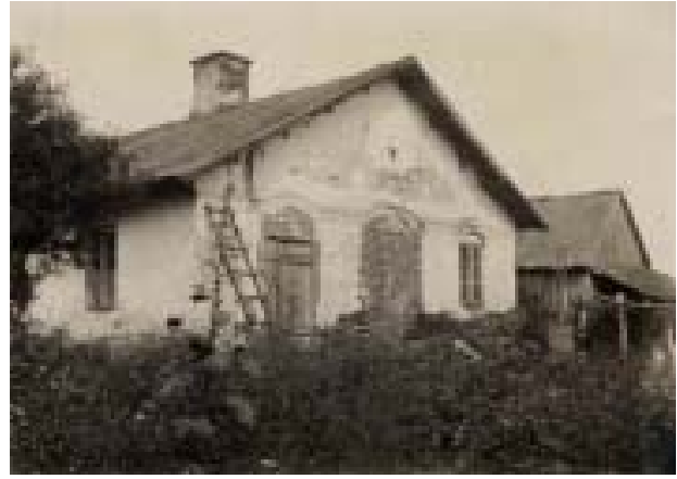
Il. 2. Oficyna, elewacja południowa, 1925, fot. Juliusz Żakowski, Zbiory Fototeki w NIFC, F.5026.
