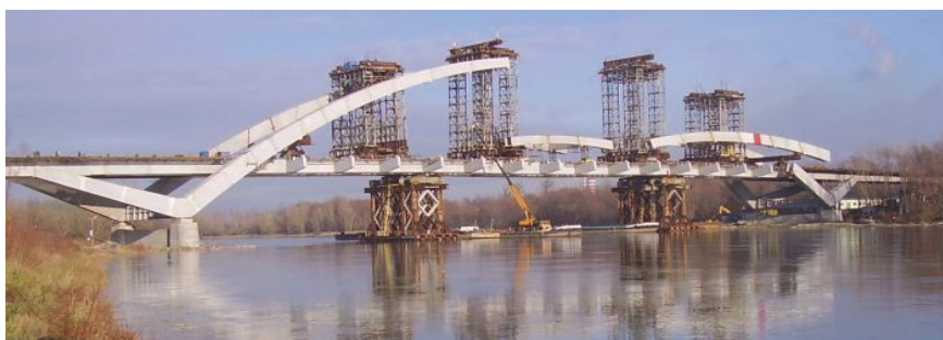
Rys.8. Elementy KD – 66C wykorzystane jako podpory montażowe przy budowie przęsła łukowego mostu w Puławach [9]
