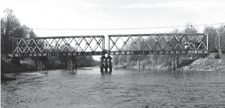
Rys. 9. Widok ogólny na most technologiczny z konstrukcji składanej KD-66C [8]
