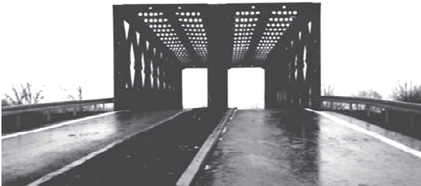
Rys. 7. Wiadukt objazdowy z konstrukcji KD -66C w m. Słabomierz [2]
