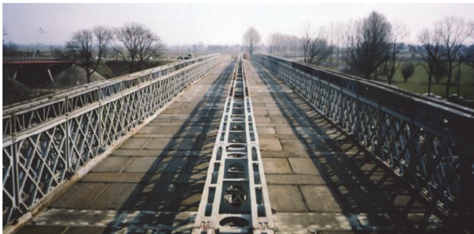
Rys. 3. Najdłuższy most objazdowy z konstrukcji DMS-65 przez rz. Wisłę w Kiezmarku, o długości 1184 m [2]
