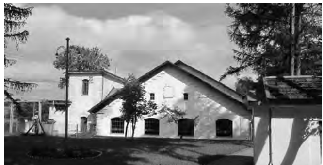
Rys. 4. Przepompownia wody w Woli Dobrostańskiej, po lewej stronie znajduje się stacja transformatorowa 30/6 kV (obecnie 35/6 kV)
