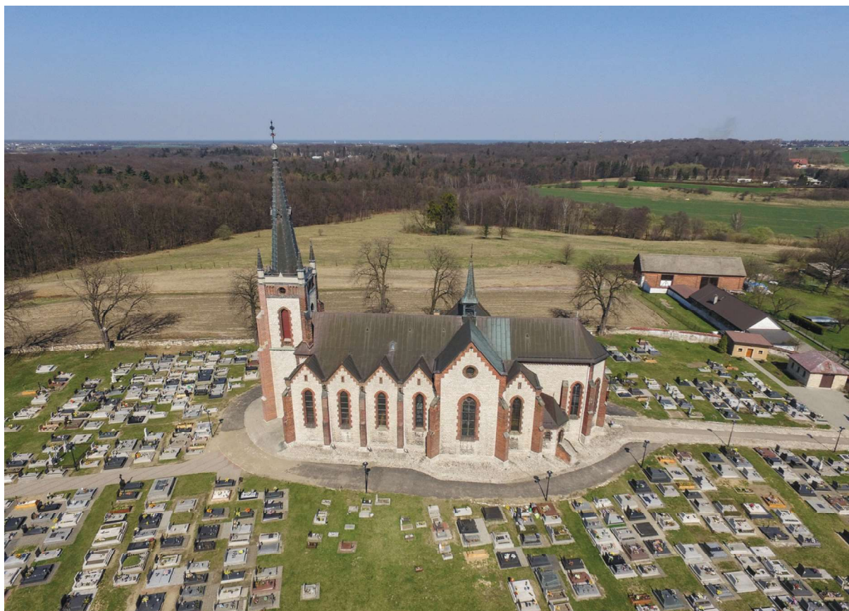
Rys. 2. Kościół pw. św. Mikołaja w Tarnowskich Górach – widok ogólny Fig. 2. St. Nicholas Church in Tarnowskie Góry - general view
