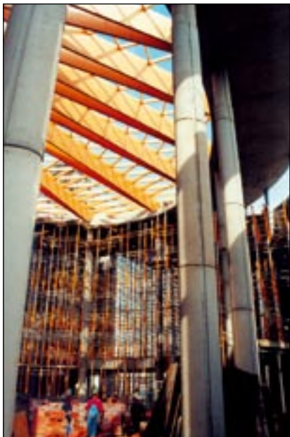
Widok wnętrza bazyliki Sanktuarium Bożego Miłosierdzia w Łagiewnikach, z eksponowaniem konstrukcji betonowych słupów oraz stropu nad nawą główną z więźarów z drewna klejonego
