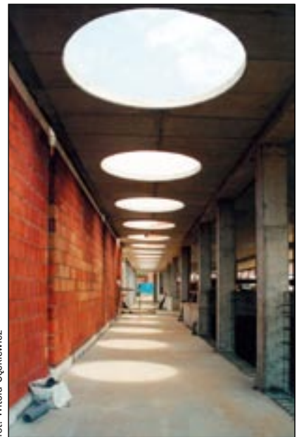
Pasaże obiegające bazylikę pozostaną w betonie jako materiale podstawowym
