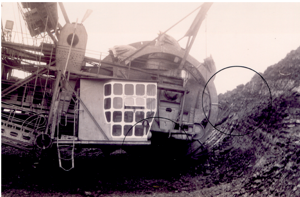
Rys. 4. Koparka SchRs-1200 po awarii układu zwodzenia – widok od strony koła czerpakowego
