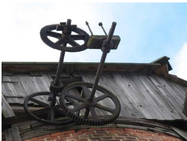
Ryc. 3. Łąkorz, wiatrak „holender”, strefa głowicy, relikty mechanizmu napędowego głowicy, widok z poziomu gruntu, stan obecny. Fot. J. Kielar, lipiec 2011
