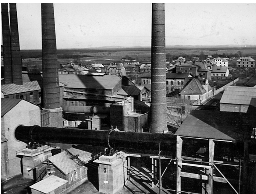
Ryc. 9. Piec obrotowy nr 6, źródło: Muzeum Miasta Jaworzna
