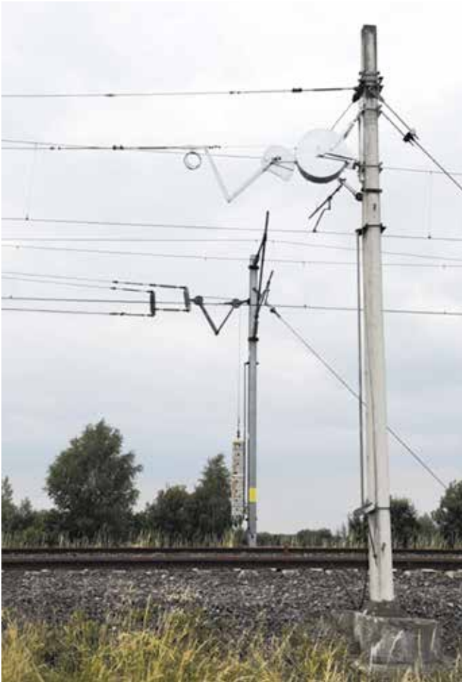
Rys. 16. Porównanie dwóch typów urządzeń naprężających na pierwszym planie prototyp nowoczesnego urządzenia bezciężarowego
