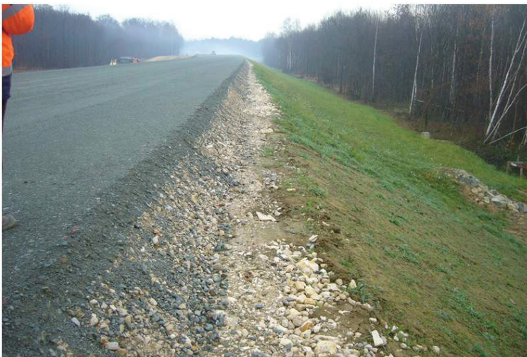
Rys. 3. Poszerzenie szczytu nasypu
