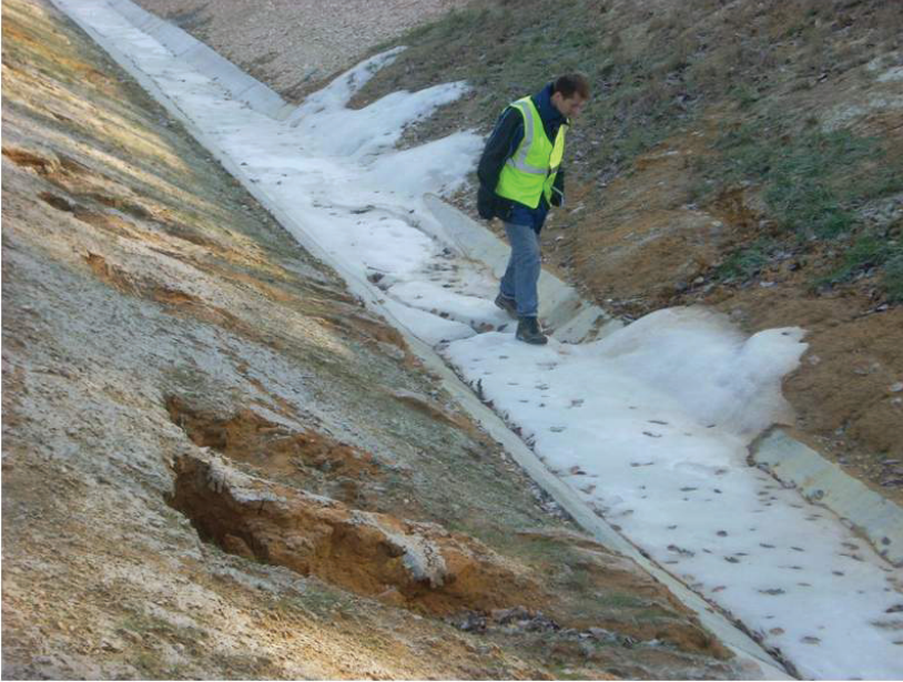
Rys. 4. Wpływanie wody na boki fosy spowodowało osłabienie ich trwałości
