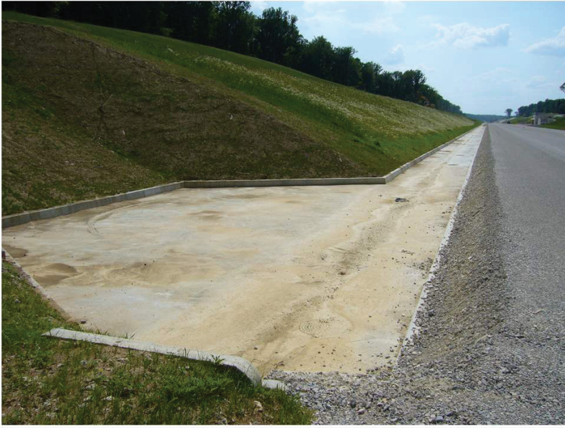
Rys. 7. Zatoka znajdująca się na poziomie kinety CAPE
