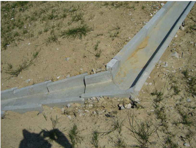
Rys. 6. Kąt prosty pomiędzy fosą na szczycie a kanałem odpływowym
