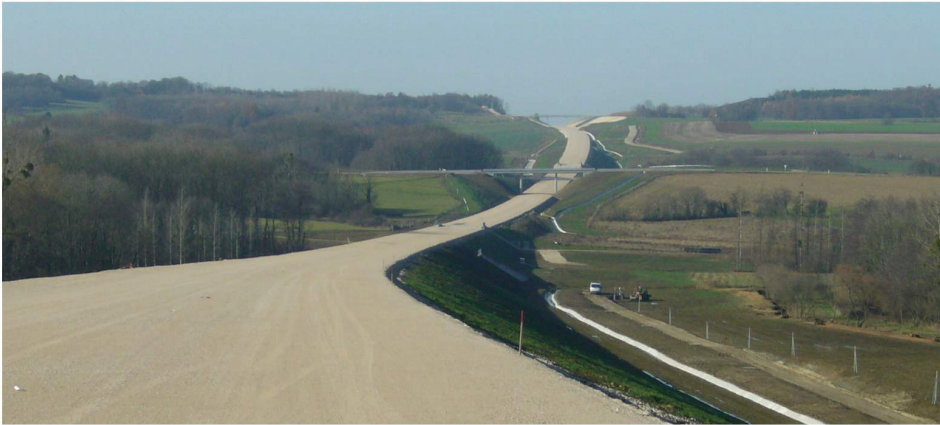
Rys. 1. Widok na budowę LGV na odcinku B3
