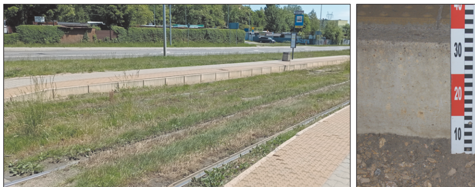
Ryc. 12. Peron po modernizacji (po lewej) i wysokość powierzchni peronu (po prawej).
