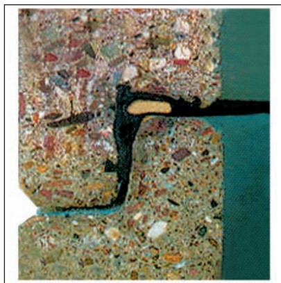
Uszczelka zintegrowana
