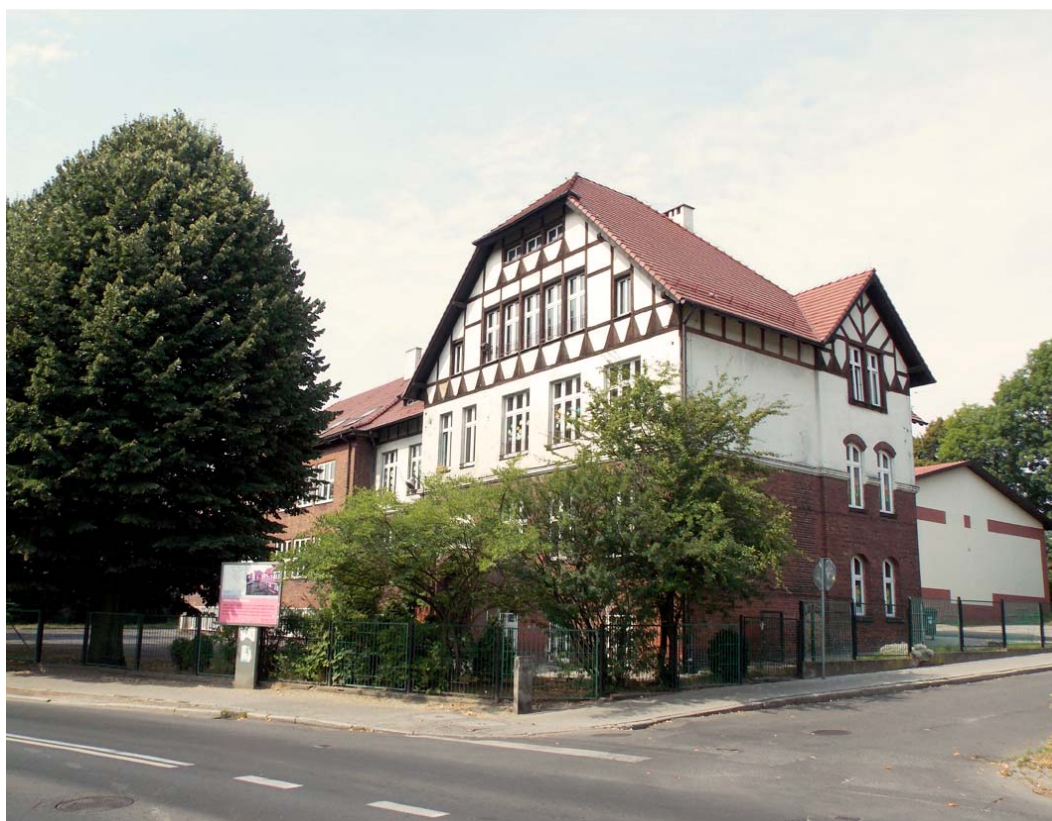
Ryc. 2. Kolonia robotnicza w Rokitnicy – budynek szkoły. Źródło: fot. autorka, 2013 r.
