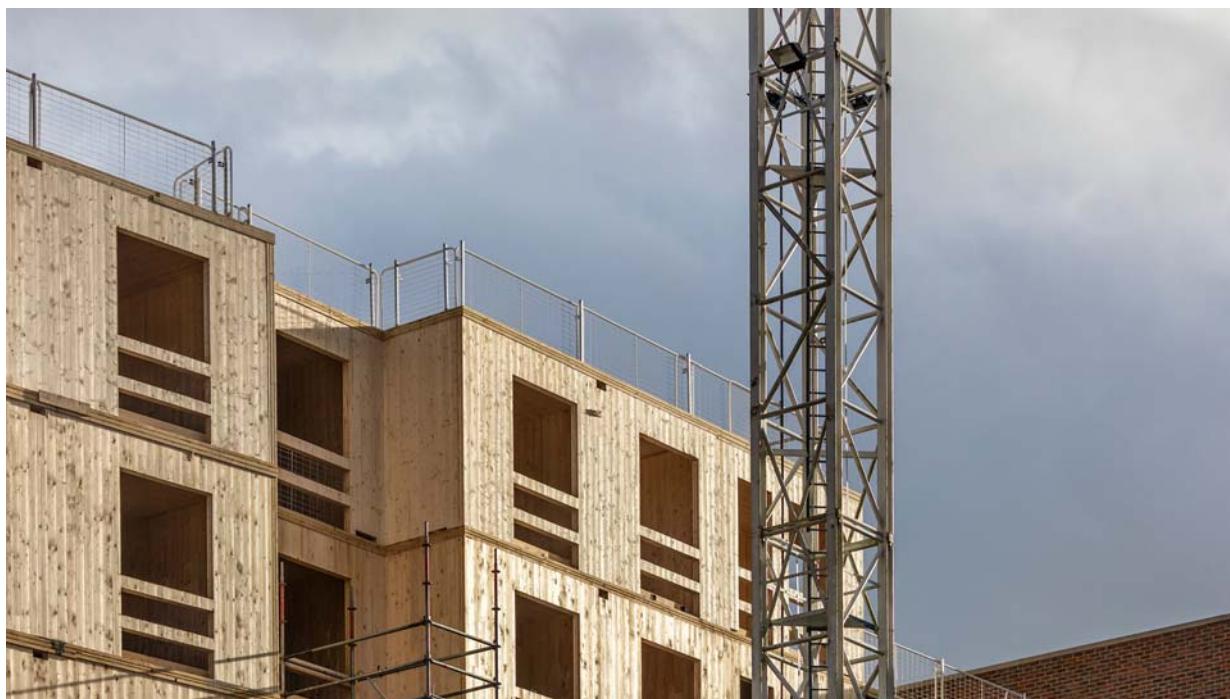
Ryc. 2. Drewniana konstrukcja budynków przy Dalston Lane – http://waughthistleton.com/dalston-lane/ (02.2017), fot. Waugh Thistleton Architects
