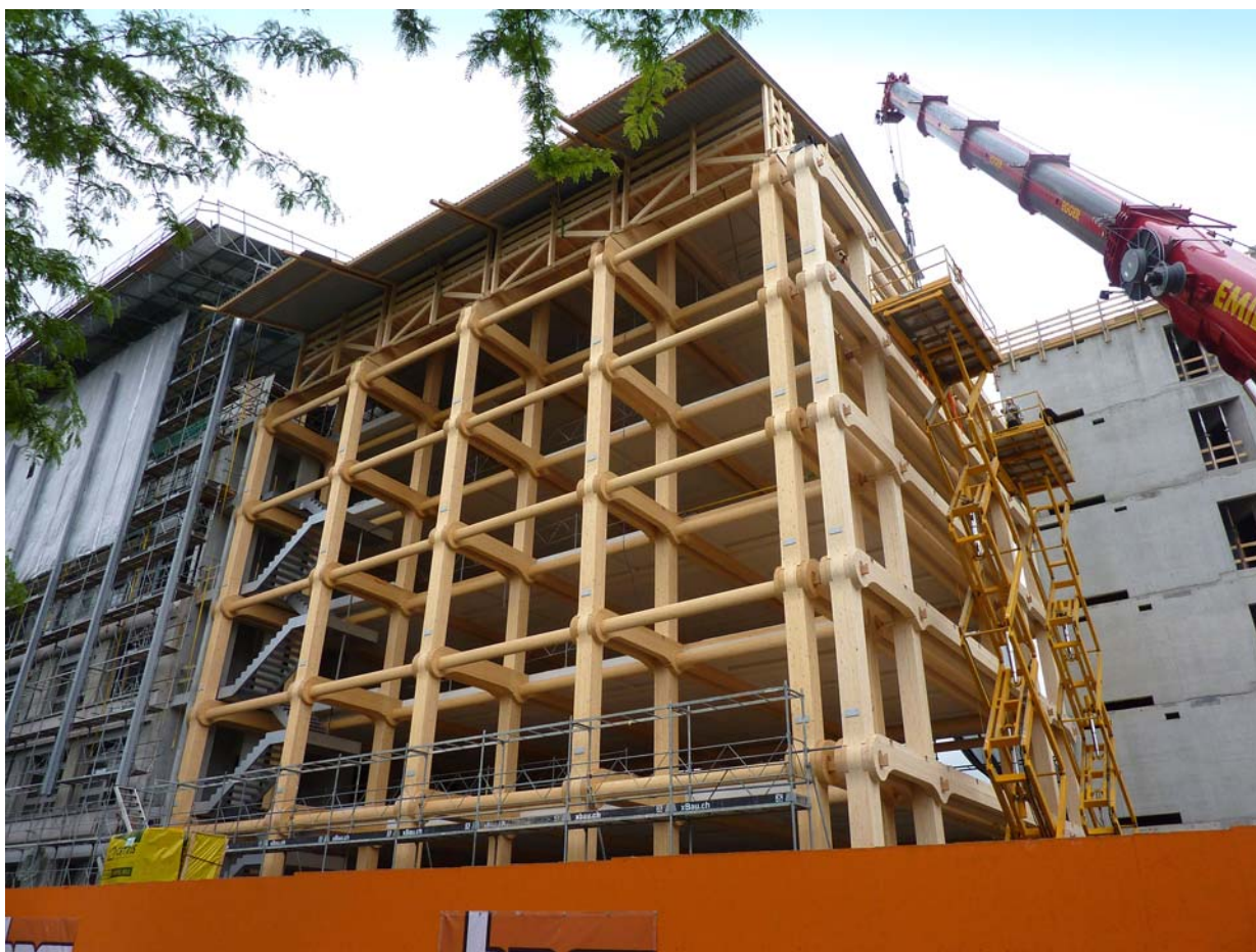
Ryc. 3. Drewniana konstrukcja siedziby Tamedia w Zurychu, fot. Shigeru Ban Architects
