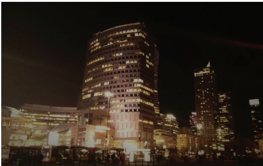
Fot. 2. Centrum Warszawy. Dominacja budynków z elewacjami w postaci ścian osłonowych.
