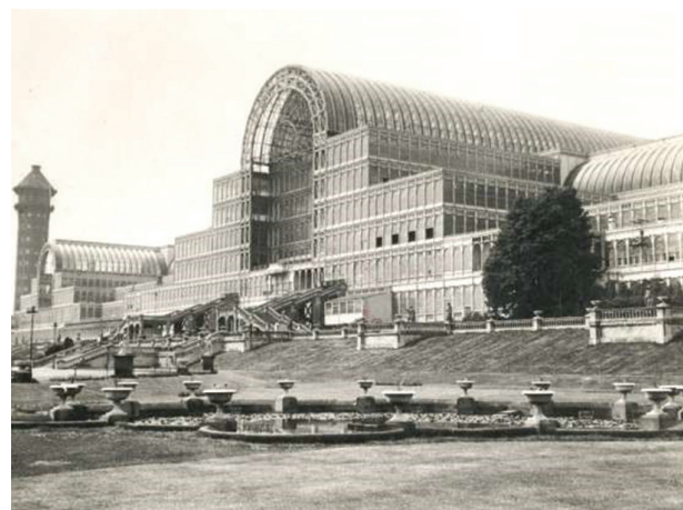
Fot. 1. Pałac Kryształowy w Londynie – pierwszy budynek z elewacją w technologii ściany osłonowej, 1910 r. (źródło: https://commons.wikimedia.org/wiki/File:The_Crystal_Palace_1910.jpg )
