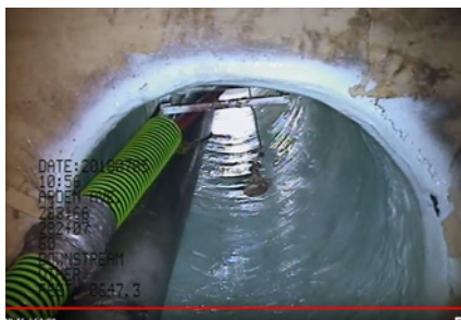
Ryc. 18. Studzienka kanalizacyjna po renowacji
