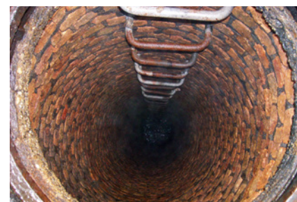
Ryc. 17. Ceglana studzienka kanalizacyjna
