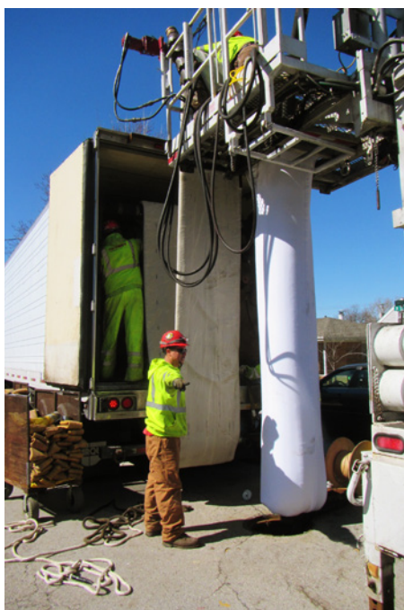
Ryc. 7. Inwersyjne wprowadzanie rękawa o średnicy 686 mm
