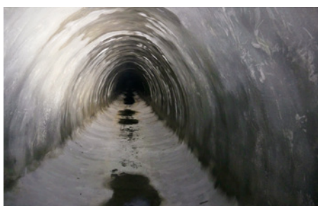
Ryc. 15. Kolektor po położeniu betonu geopolimerowego GeoKrete
