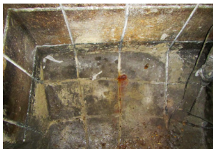
Ryc. 20. Nacięcia na ścianach komory
