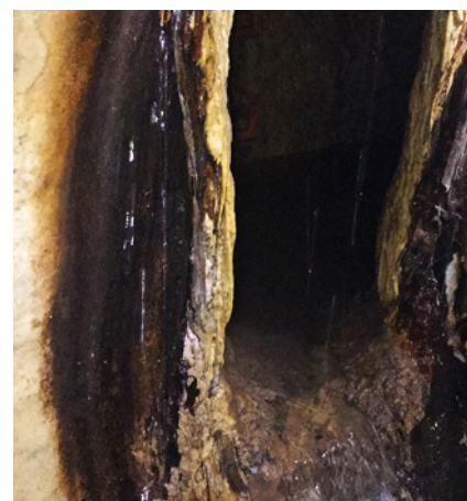
Ryc. 21. Pęknięcie (lewy) i rozwarstwienie od ściany przy połączeniu z kolektorem (prawy)
