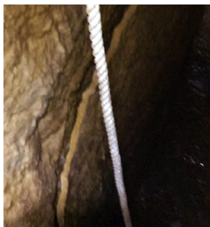
Ryc. 21. Pęknięcie (lewy) i rozwarstwienie od ściany przy połączeniu z kolektorem (prawy)
