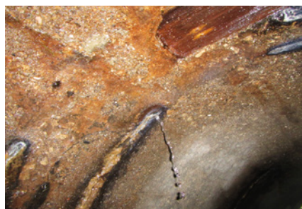
Ryc. 3. Typowe problemy wewnątrz kolektorów: a – wyrwa w podłodze kolektora, b i c – infiltracja, d – ubytek betonu w ścianie kolektora
