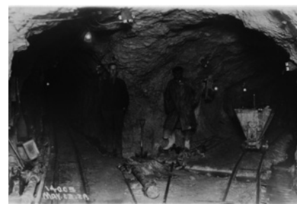
Ryc. 2. Komora nr 1 podczas budowy w 1927 r.
