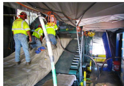
Ryc. 8. Wtrysk żywicy poliestrowej
