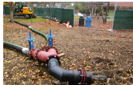
Ryc. 6. Instalacja bajpasu na terenie ogrodu zoologicznego
