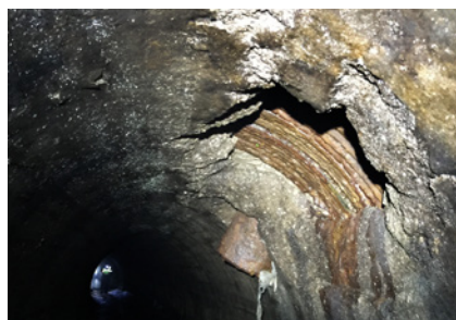
Ryc. 3. Typowe problemy wewnątrz kolektorów: a – wyrwa w podłodze kolektora, b i c – infiltracja, d – ubytek betonu w ścianie kolektora
