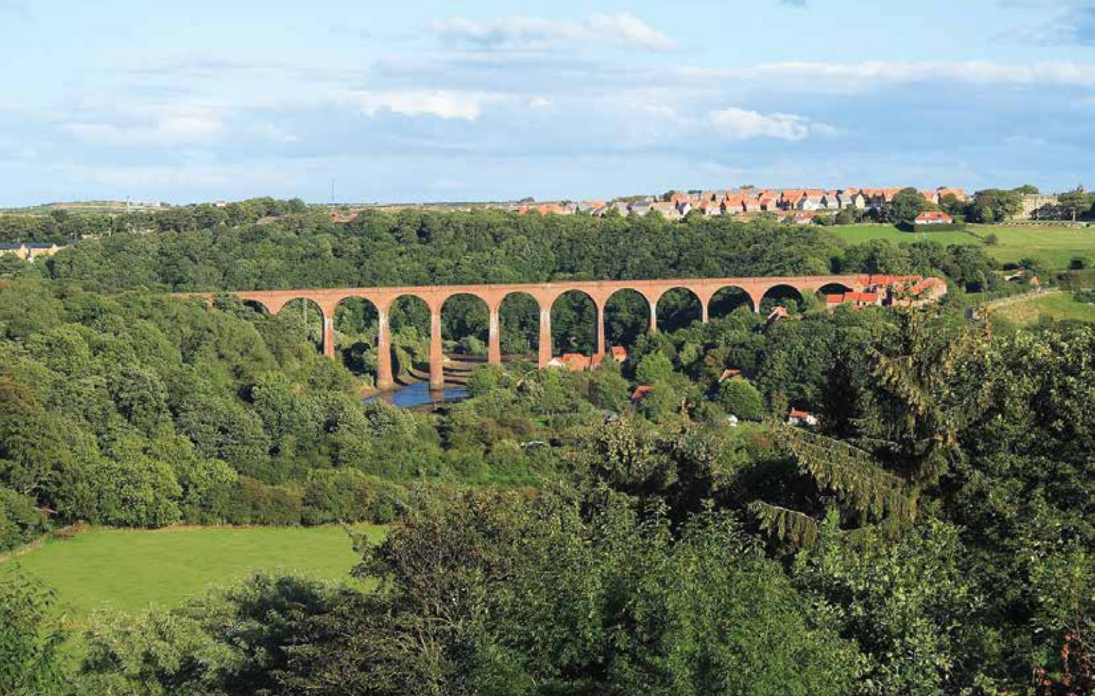
Il. 1. Whitby (Anglia) – Larpool Viaduct przez rzekę Esk nieczynnej Scarborough & Whitby Railway z 1884 r. stanowi, prócz zabytku inżynierii, wartościowe dopełnienie krajobrazu. Dzisiaj wiedzie nim droga rowerowa, fot.: Acasson, 2016, WikiComm, CC 4.0.
