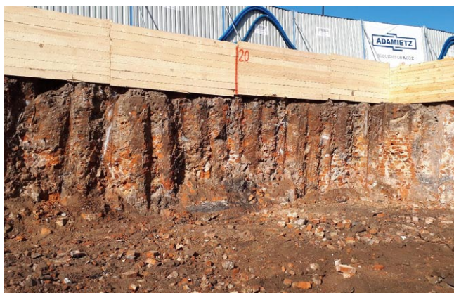
Rys. 7. Palisada po odkopaniu (archiwum Keller Polska)
