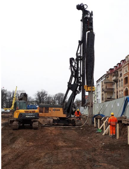
Rys. 6. Wykonywanie pali CCFA (archiwum Keller Polska)
