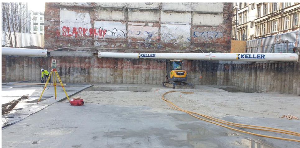
Rys. 11. Odkopana palisada przy istniejącym budynku (archiwum Keller Polska)
