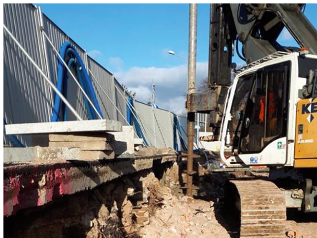
Rys. 3. Wykonywanie kolumn DSM stanowiących elementy obudowy wykopu (archiwum Keller Polska)
