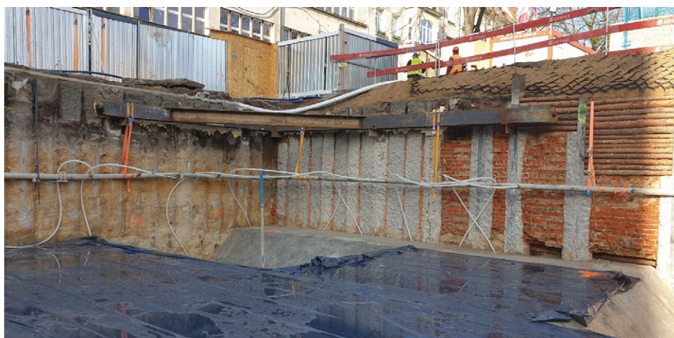
Rys. 12. Odkopana obudowa berlińska – wyraźnie widoczne pozostałości murów ceglanych (archiwum Keller Polska)
