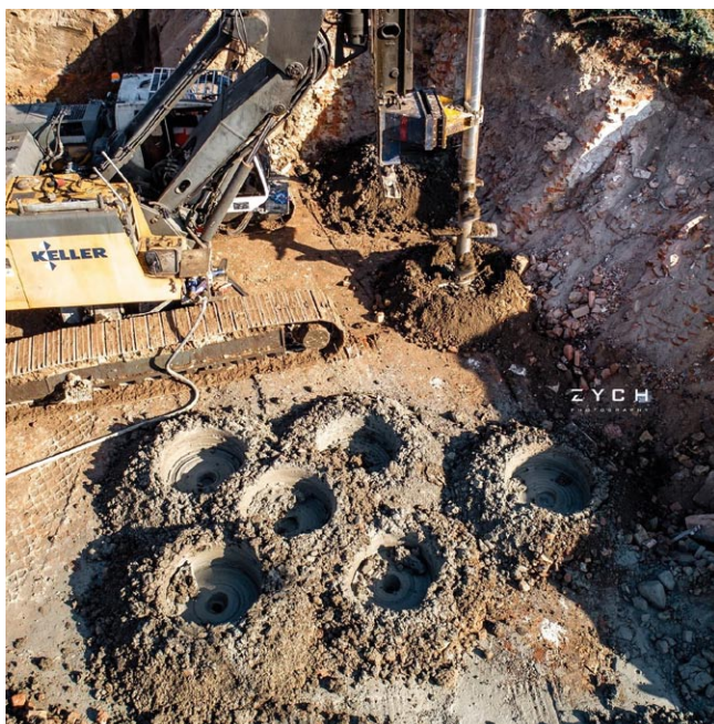
Rys. 4. Wykonywanie kolumn DSM stanowiących wzmocnienie podłoża pod płytą fundamentów ( https://www.facebook.com/photo/?fbid=2125713410828456&set=a.2033201043413027 )
