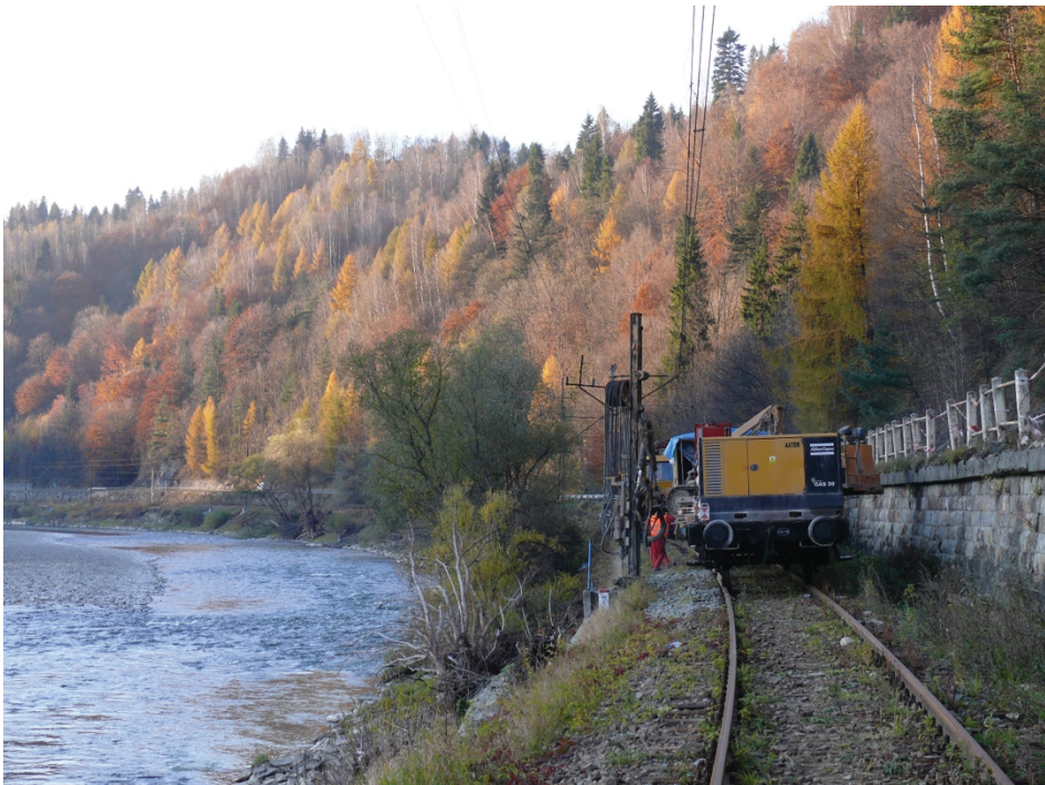
Fot. 2. Wzmocnienie fundamentów słupów trakcyjnych, Piwniczna (materiały firmy Soley Sp. z o.o.)
