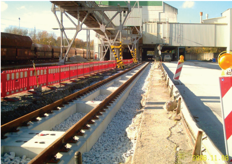
Fot. 5. Nawierzchnia kolejowa bezpodsytkowa NFF po wykonaniu, Kalkwerk Wulfrath
