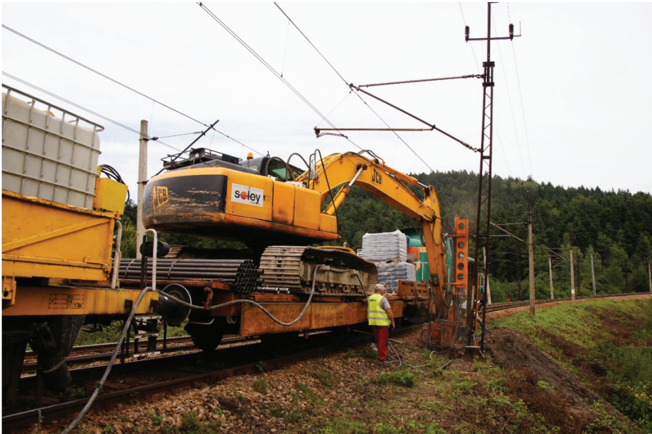
Fot. 1. Instalacja mikropali pod słupy trakcyjne, Ptaszkowa (materiały firmy Soley Sp. z o.o.)
