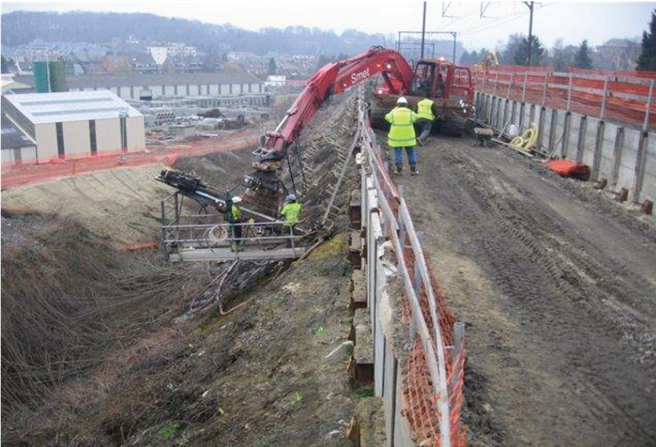
Fot. 4. Wykonanie gwoździ gruntowych dla dobudowy toru, linia kolejowa Schaerbeck-Namur
