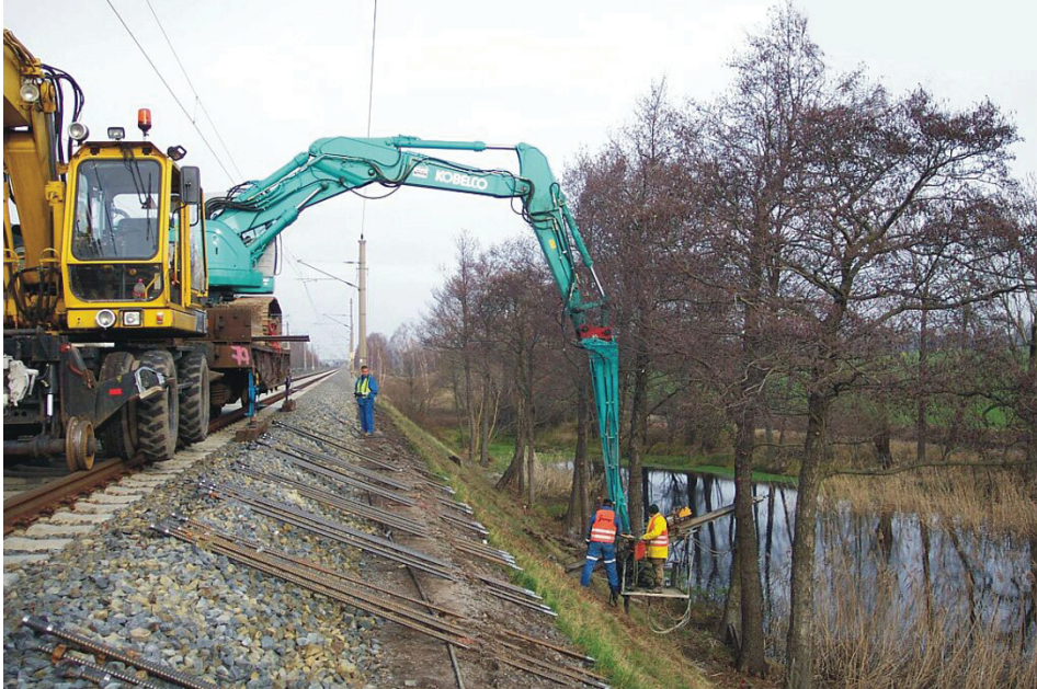
Fot. 3. Wzmocnienie nasypu przez gwoździowanie z instalacją z toru, linia kolejowa Großenhain-Frauenhain
